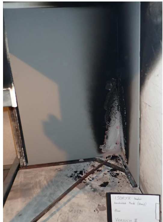
Bild 12: Prüfkörper nach der Prüfung, Gesamtansicht
