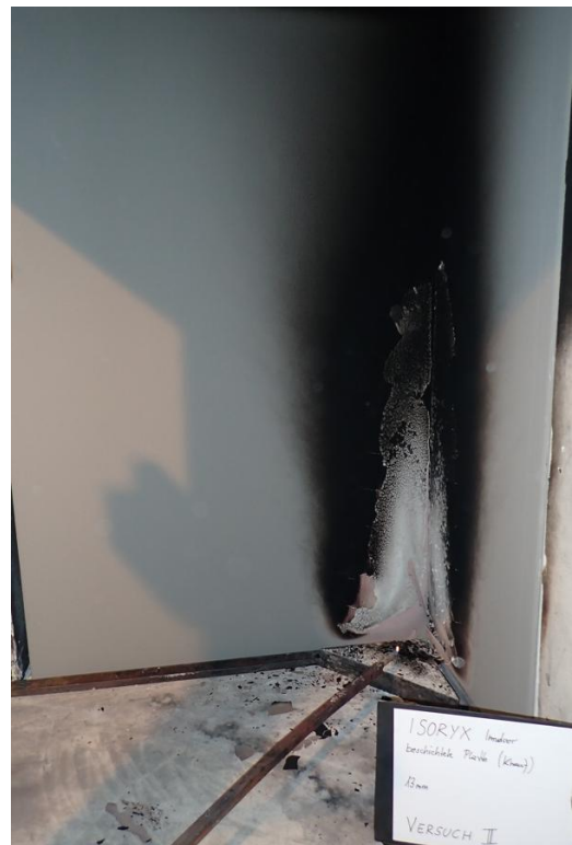
Bild 8: Prüfkörper nach der Prüfung, Gesamtansicht
