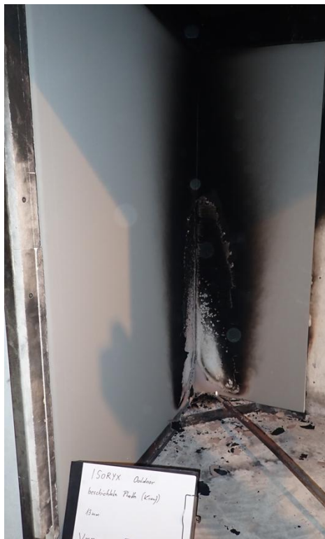
Bild 7: Prüfkörper nach der Prüfung, Nahaufnahme der Außenkante
