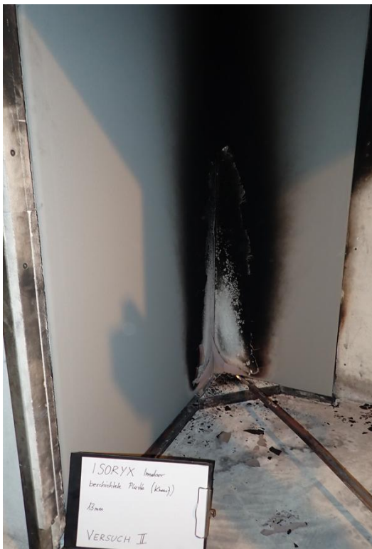
Bild 7: Prüfkörper nach der Prüfung, Nahaufnahme der Außenkante
